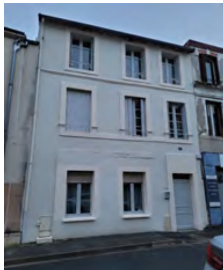
Façade refaite - rue des Forges
