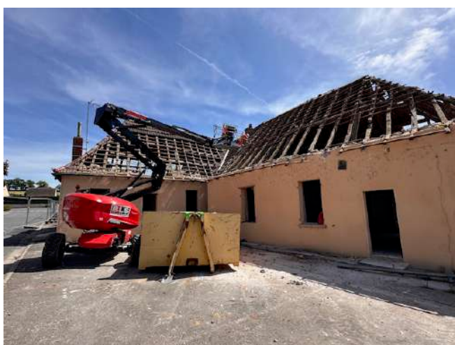
Opération démolition des anciens pavillons
